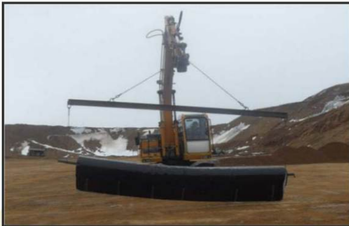
Рисунок 3.14 Траверса для транспортировки и укладки рулонов бентонитового мата
